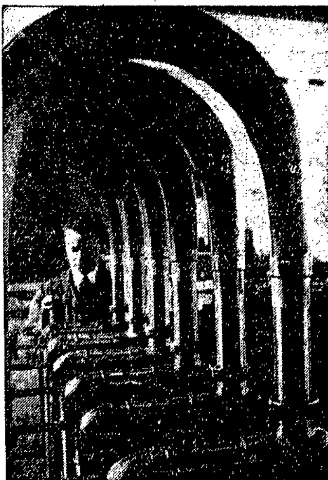
Blick in die Zentrale der Reichspost.
