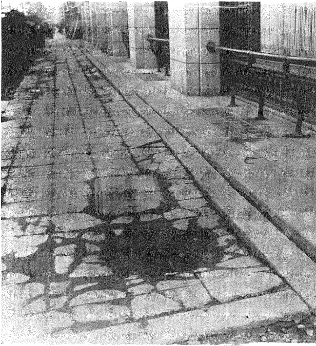
(7) 鋼矢板を引抜きし際歩道沈下の状況
