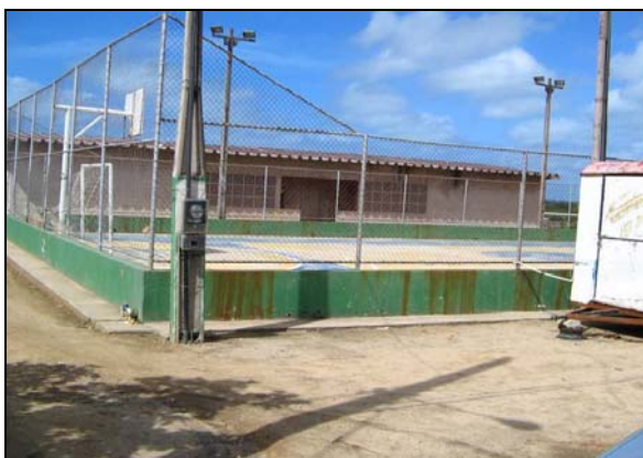
Figura 4.3.1.1.1-1: Escola em vias de finalização e quadra de esportes - Ago/06.
