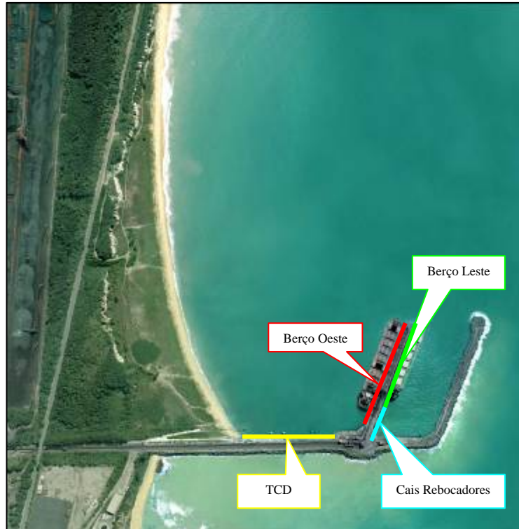
Figura 2.3.1.1-2: Vista da estrutura dos cais de atracção do Terminal Marítimo Privativo de Uso Misto da Ponta de Ubu.
