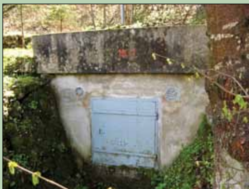
Slika 116: Javni vodovod in vodohran za Metelnikom iz leta 1961, 2008.
