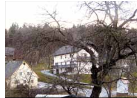
Komarjeva hiša stoji na mestu nekdanje pritlične hiše, ki so jo porušili in na istem mestu zgradili sedanjo veliko dvodružinsko stavbo, 2008.
