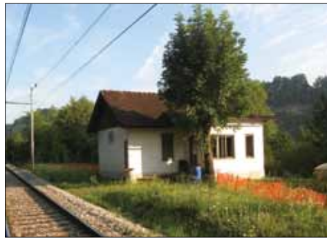
Mišače št. 15: železniška čuvajnica, 2008.
