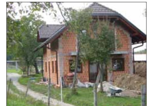
Mišače 5a: Hiša Stane Sitar v gradnji 2008.
