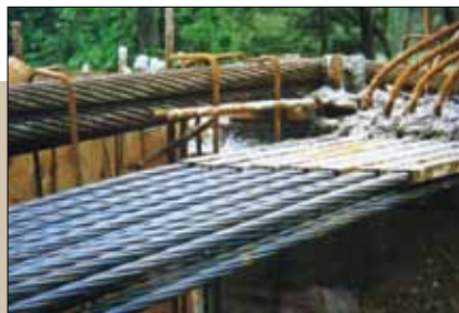
Slika 125: Nosilne žične vrvi so skrite v notranjosti mostu.
