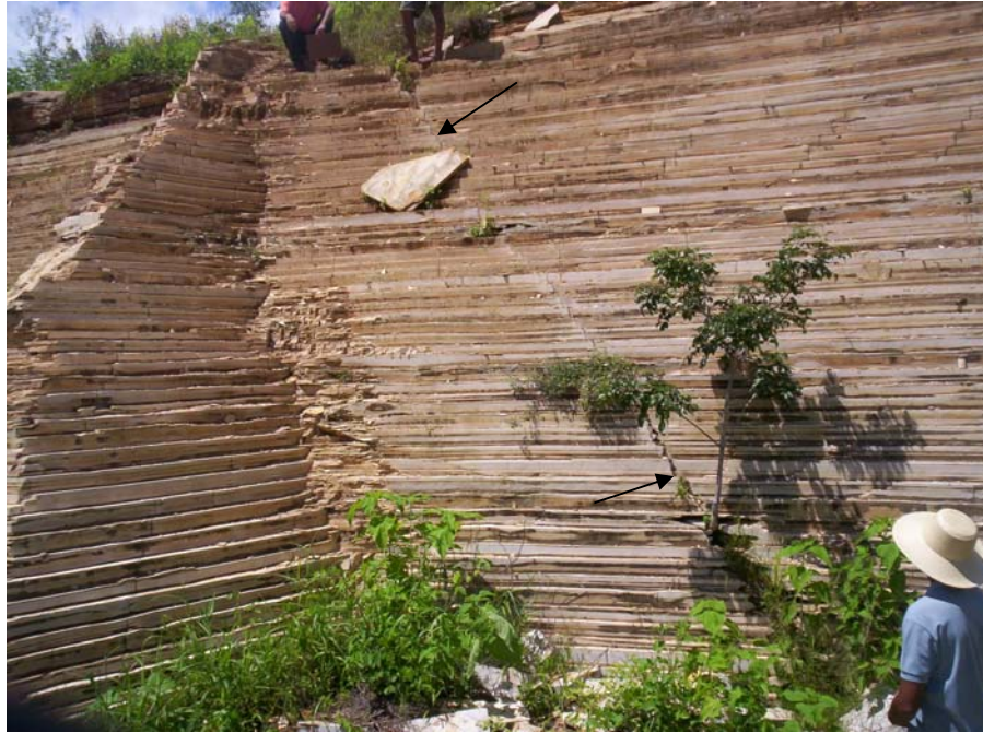
Foto 5.18 – Fraturas fechadas com pouca penetração de água e material superficial (do autor).
