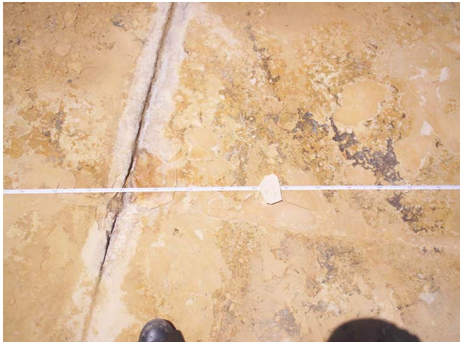
b) Parte dos trabalhos detectando fratura aberta cortando a scanline .
