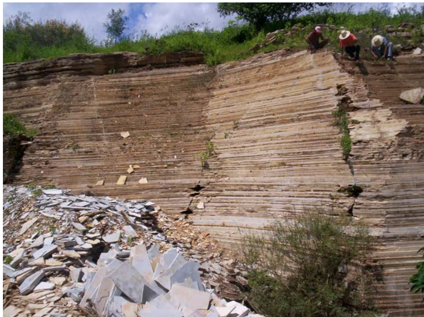
Foto 5.19 – Fraturas abertas, preenchidas por material decomposto (do autor).
