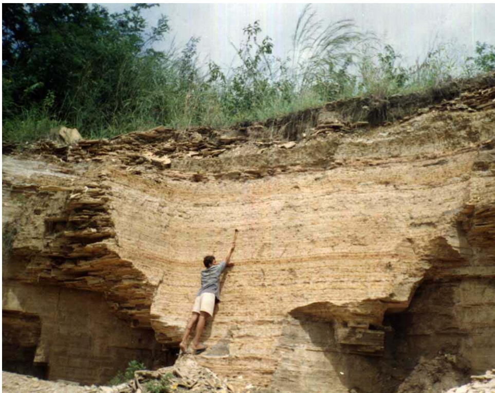
Foto 8.3 – Pedreira próxima do Idemar, afloramento 4, em que a atividade inicial mal executada pode proporcionar instabilidade na seqüência geológica e deformar a topografia local trazendo fortes riscos para os trabalhadores (Oliveira, 1998).
