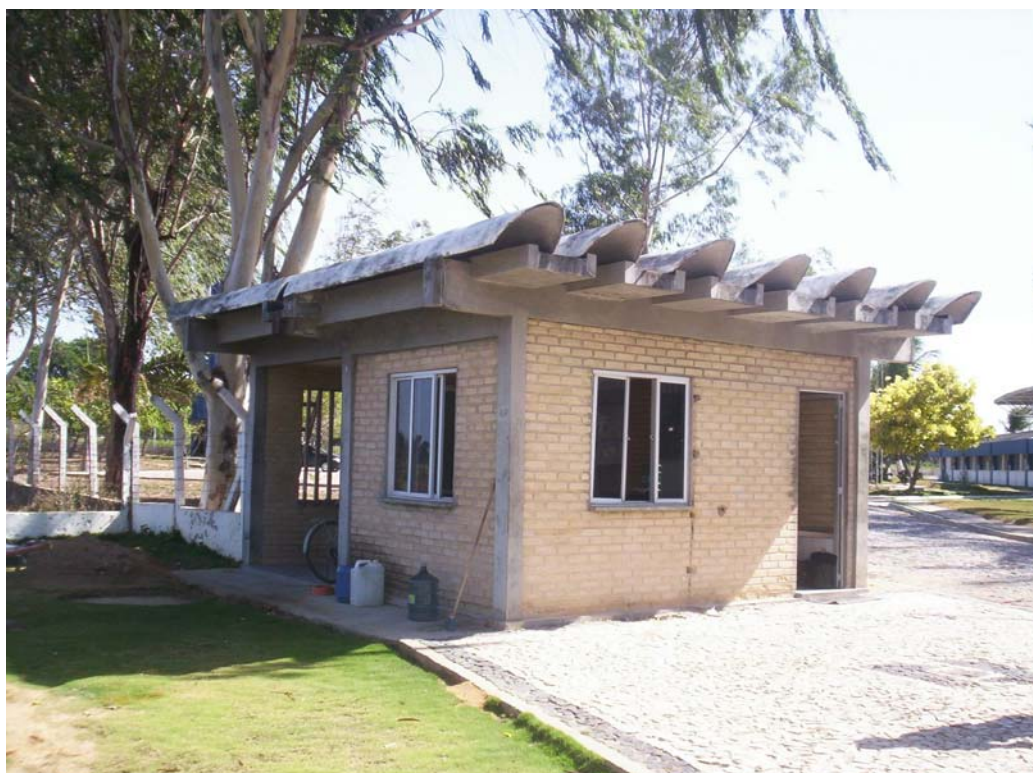
Foto 7.7 – Visão lateral da guarita do NUTEC, no campus da UFC, em Fortaleza, mostrando a entrada de visitantes para a Recepção, onde é feita sua identificação (do autor).
