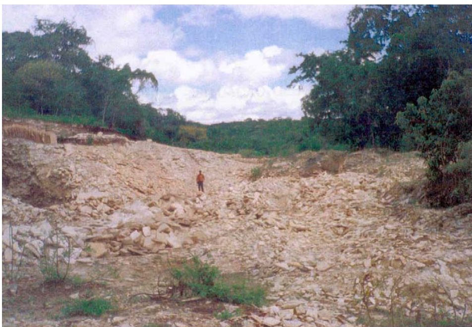
Foto 8.1 – Pedreira de Massapé do Livramento, na encosta oposta (oeste) do afloramento 4, cheia de entulho inclusive dentro de linha de escoamento de água, assoreando riacho na parte superior do declive (Oliveira, 1998).
