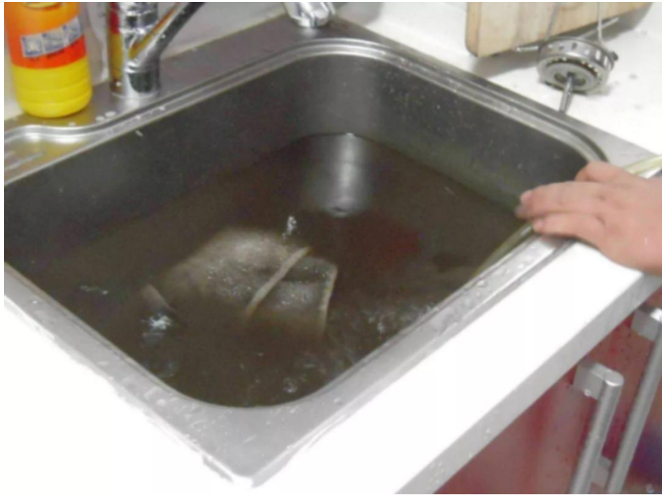
图 1-1 厨房下水管道堵塞情况
