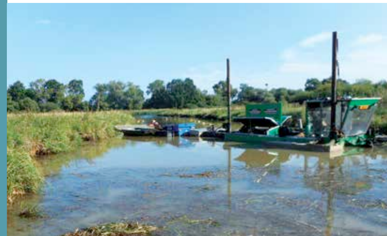
Schwimmbagger im Einsatz. Für den Baggerführer, der schnell auf wechselnde Bodenbeschaffenheit reagieren muss, ein Job, der viel Erfahrung erfordert.
