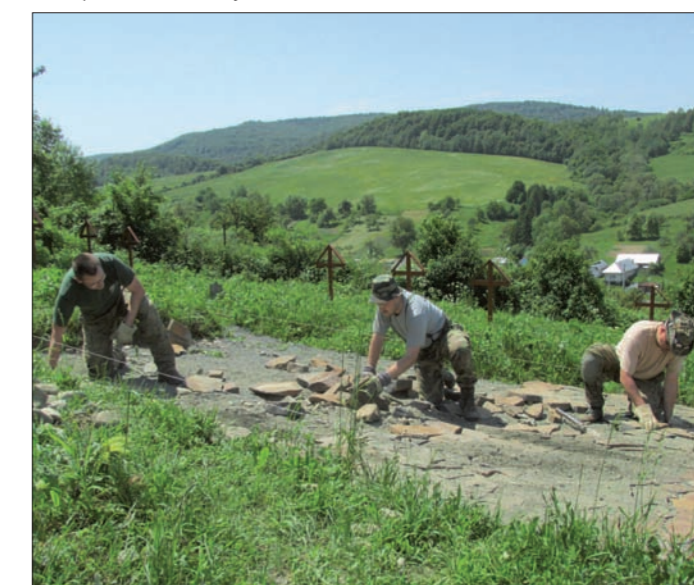
Práce pri rekonštrukcii vojnového cintorína v Hostoviciach
