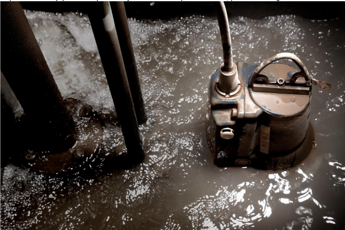
KUVATEKSTI: Jätevesikaivoissa perinteiset pintavivat ovat koetuksella. Ne keräävät likaa ja aiheuttavat tarpeettomia hälytyksiä. Kun pinnanohjausta hallitaan paineanturilla, perinteiset ongelmat häviävät.
