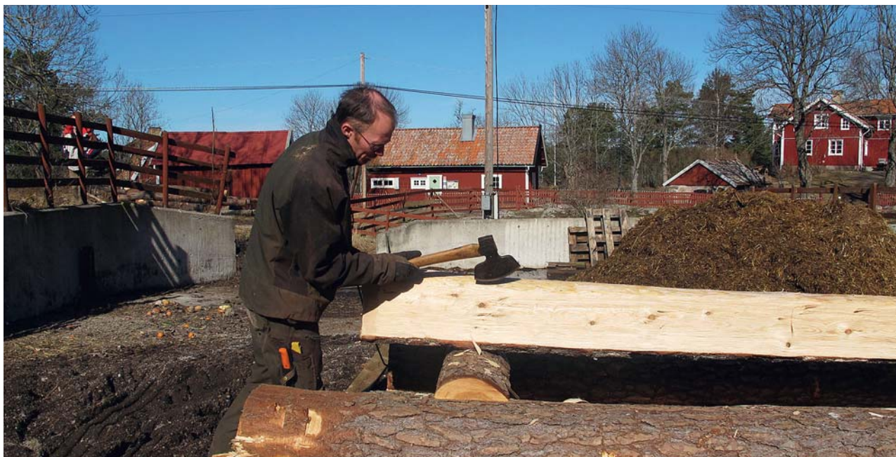
Timmer till renoveringen av ladan vid Västergården kommer från skogen på ön.
