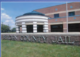
Bergen County Jail 820 MOBOTIX Kameras, USA
