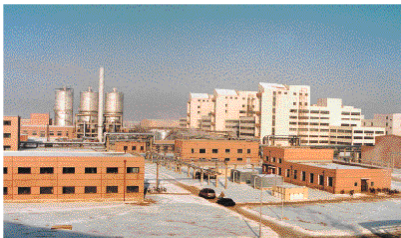
Liao Yang polyester plant - China
