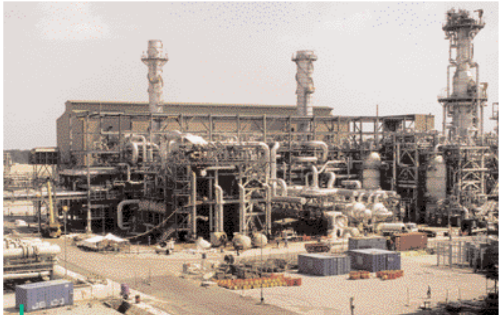
Second LNG train delivered at Bonny (Nigeria).
