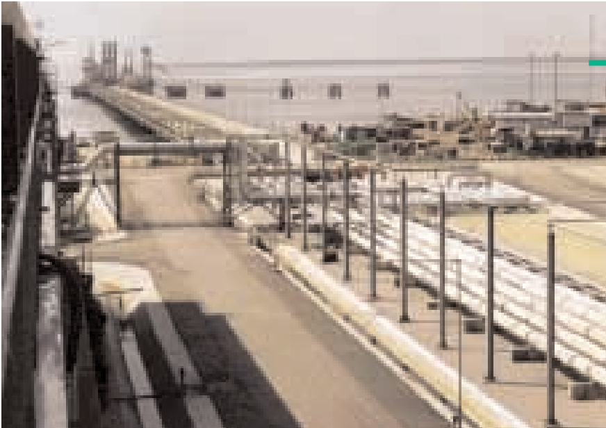
Loading jetty for the LNG complex at Bonny (Nigeria).
