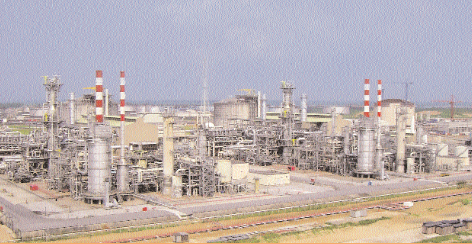
View of the Bonny LNG complex, Nigeria.
