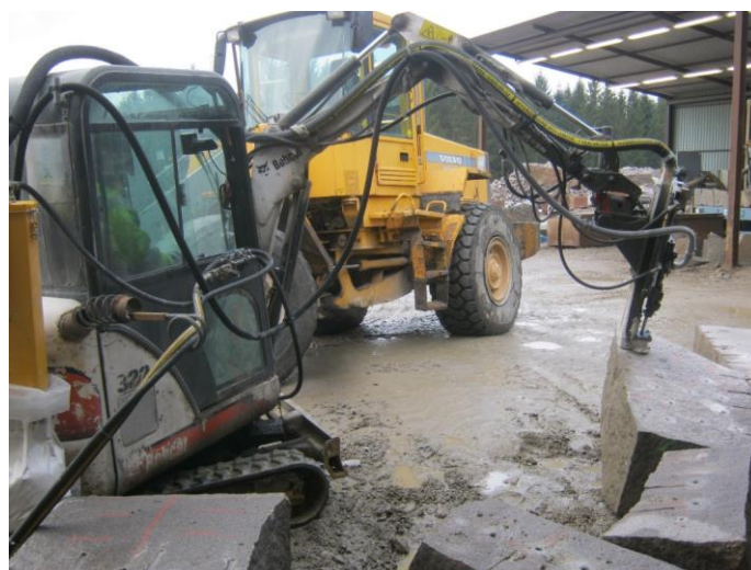
Borrarborring av kilhål. BBD 12 monterad på Bobcat. Lastaren i bakgrunden
