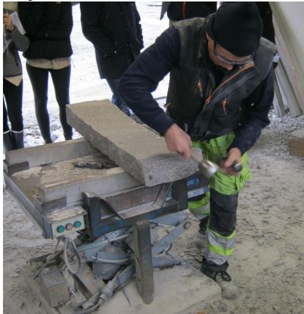
Tillsättning av kantsten
