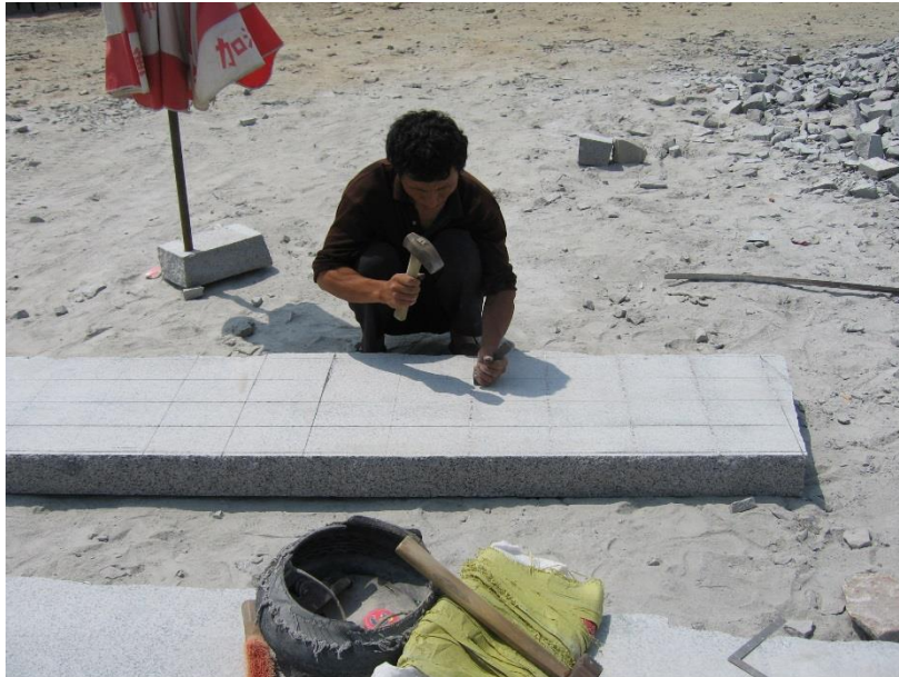
Kilning av flammad skivat till gatsten Bild 3003
