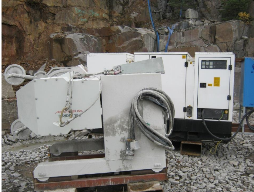
Elverk och diamantlinsåg. (Sågen ej i arbete på bilden)
