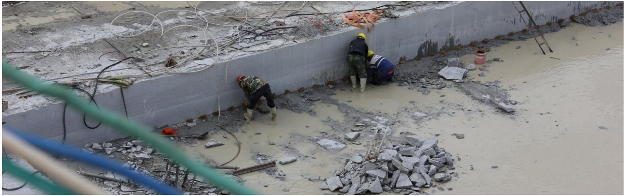
Bild 0340 Borring och kilning av svall
