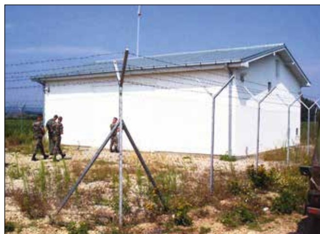
Figure 2 : Périmètre de protection immédiate d'un captage d'eau. La zone fait l'objet d'une protection physique vis-à-vis des intrusions et n'héberge aucune installation pouvant constituer une source de pollution des eaux. Le bâtiment abrite la tête de forage et les matériels de traitement de l'eau.
