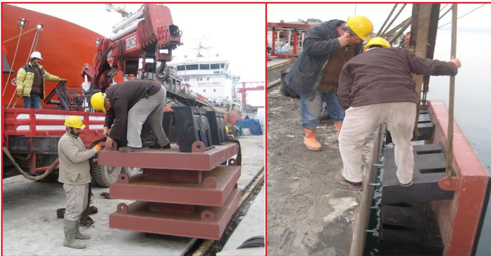
Şekil 5.19: Rıhtıma bir usturmaçanın yerleştirilmesi
