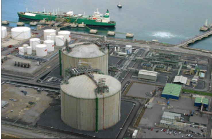
BBG's new LNG terminal at Bilbao – Spain is now Europe's largest LNG importer.
