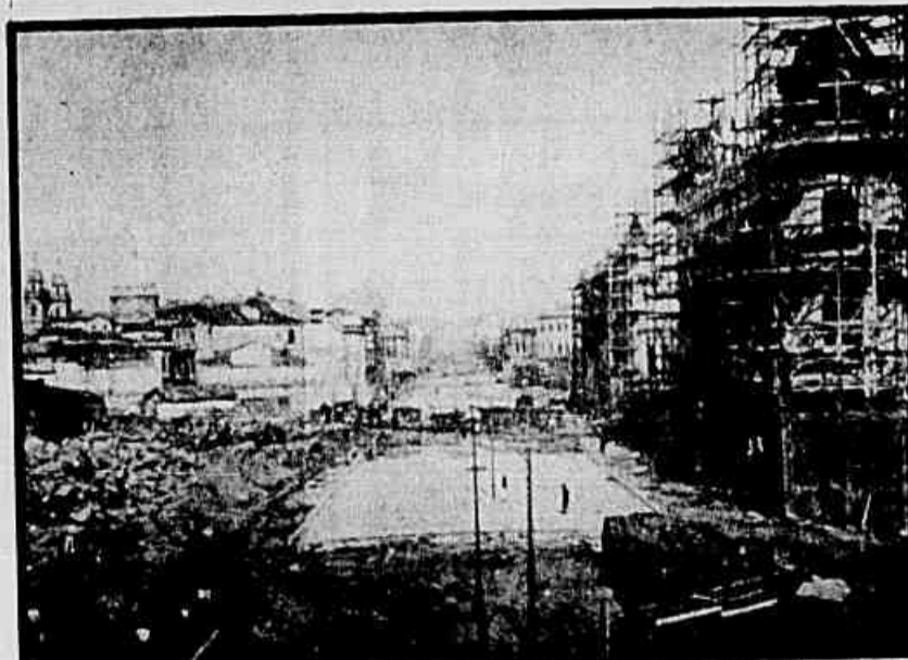
Pereira Passos fez do Centro um grande canteiro de obras
