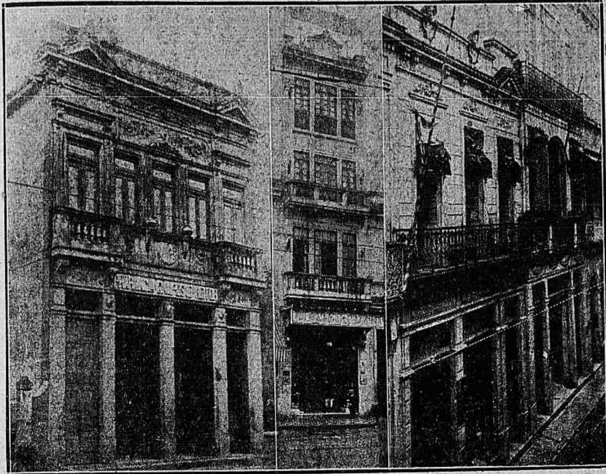
Facçadas dos predios em que funcionam os estabelecimentos da firma Heitor Gomes & C. ás ruas Vinto e Quatro de Maio, Conceição (Nietheroy) e Alfandega
