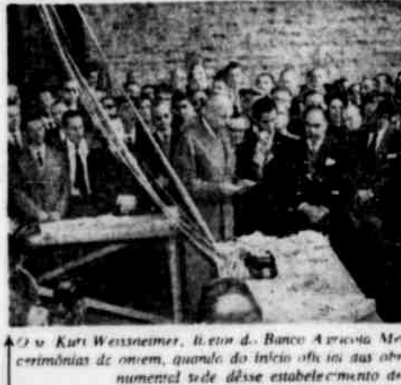
O sr. Kurt Weissheimer, diretor do Banco Agrícola Mercantil, discursou por ocasião das cerimônias de ontem, quando do início oficial das obras de construção da nova e monumental sede desse estabelecimento de crédito do RGS.
