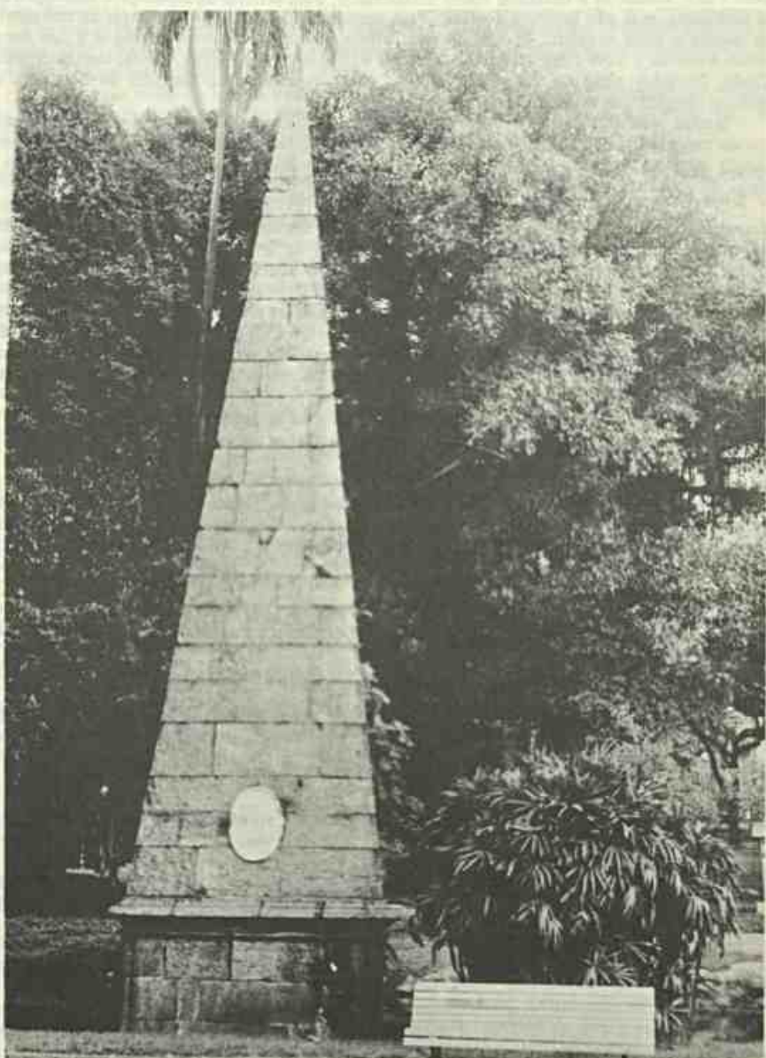
Uma das pirâmides já desprovidas completamente da hera
