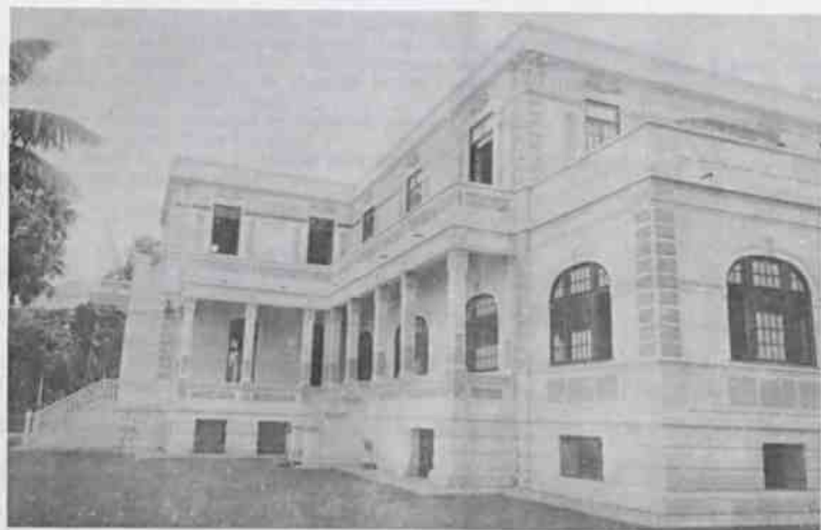
Prédio da Administração do Jardim Botânico do R.J. em seu aspecto original (Fotos de 1931, dos arquivos do J.B.).
