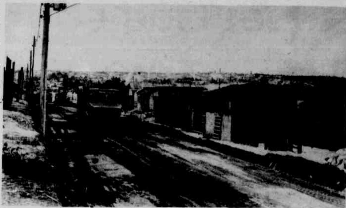
A PMM já começou as obras de urbanização do bairro Amazonino Mendes, com serviços de limpeza, terraplenagem e retirada de entulho e lixo
