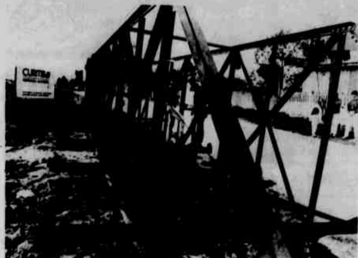
As passarelas de metal estão sendo construídas pela Secretaria Municipal de Obras Públicas
