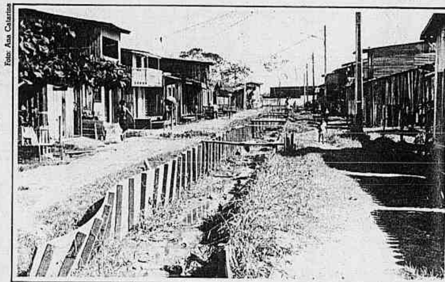
Mullos terrenos da Radional II continuam irregulares com moradores à espera de títulos
