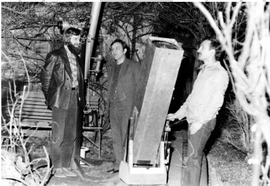
Kecskeméti amatőrök az 1980-as évek elején. Balról jobbra: Újvárosy Antal, Papp Sándor és Berente Béla. Papp Sándor 25 cm-es Newton-távcsöve horizontális finommozgatással ellátott azimutális állványt kapott
