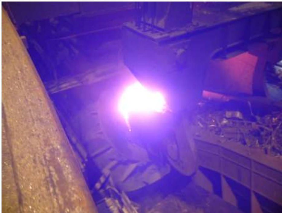
3.19. ábra Az acélhulladék beöntése a hulladékadagoló kanállal
