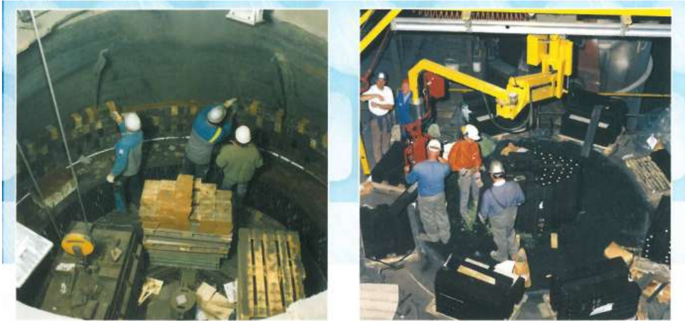
2.13. ábra Konverter falazatának kialakítása
