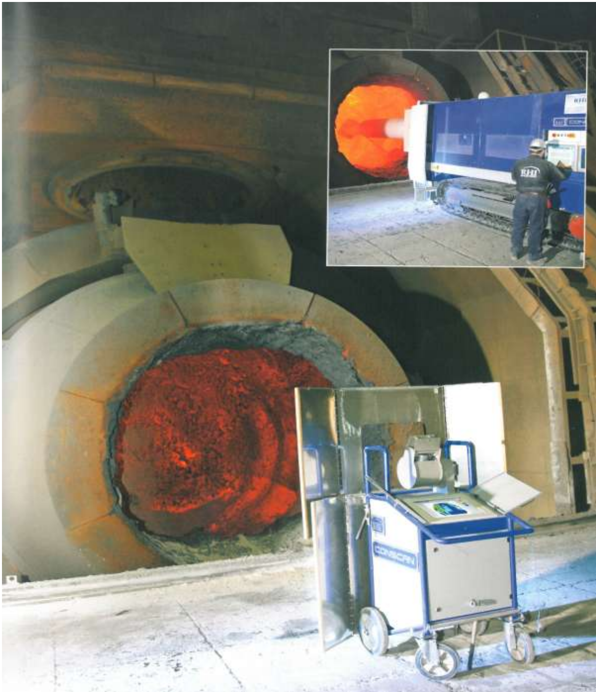
3.2. ábra Falazatjavítás felszóró-géppel
