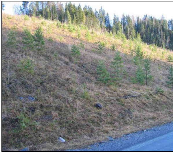
Figur 3. Bildet viser fyllingen som skrår ned mot Kaggefossveien. Bildet er tatt mot øst. Furu har etablert seg over hele fyllinga.
