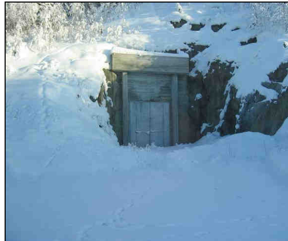
Figur 13. Tunnelen som ble lagd i forbindelse med effektiviseringen av Kaggefoss kraftstasjon inngår i dette arealet.
