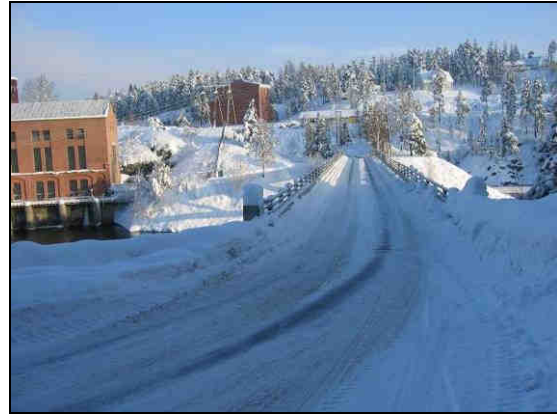
Bru over Snarumselva, veibredde på 4 m.
