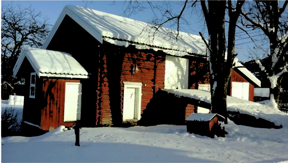
Eldste del av driftsbygningen på Pladsen under Kaldaker på Stalsberg skal være bygd før 1700, men den skal være bygd om flere ganger. Hoveddelen har form som en klassisk treromslåve. Ved registreringen i 1991 var det innredet fjøs i rommet til venstre for treskelåven, slik at den framstår som en liten enhetslåve. På hver side er do og garasje bygd til.
