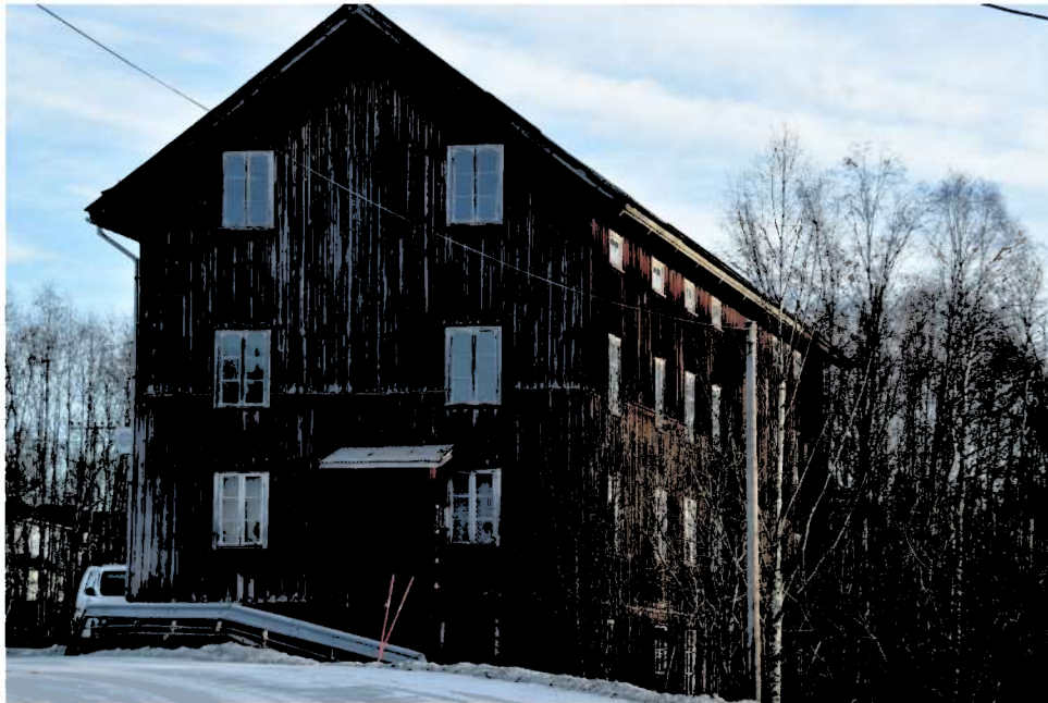
Bygningen ligger inntil Syslebekken.
