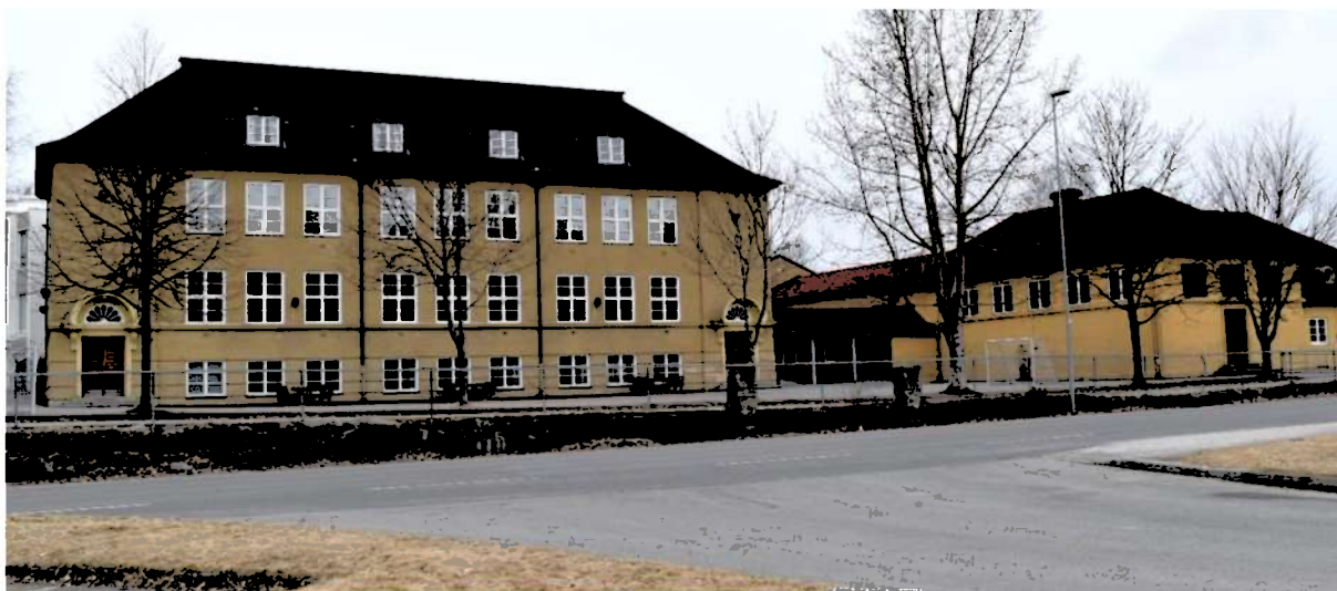
Stalsberg skole på Geithus var en av landets mest moderne skoler da den sto ferdig i 1923. Den er tegnet av arkitekt Henrik Nissen, og skapte stor oppsikt utover landet på grunn av sin størrelse og flotte utstyr. Det var 10 klasseværelser, gymnastikksal, andre spesialrom og vaktmesterbolig. Arkitekturen speiler husets status og er typisk for 1900-tallets nybarokk. Karakteristisk helvalmet tak, her med en liten svai ved takfoten, og rikt profilerte overstykker ved inngangene med muslingskallmotiv som hviler på svulstige konsoller.
