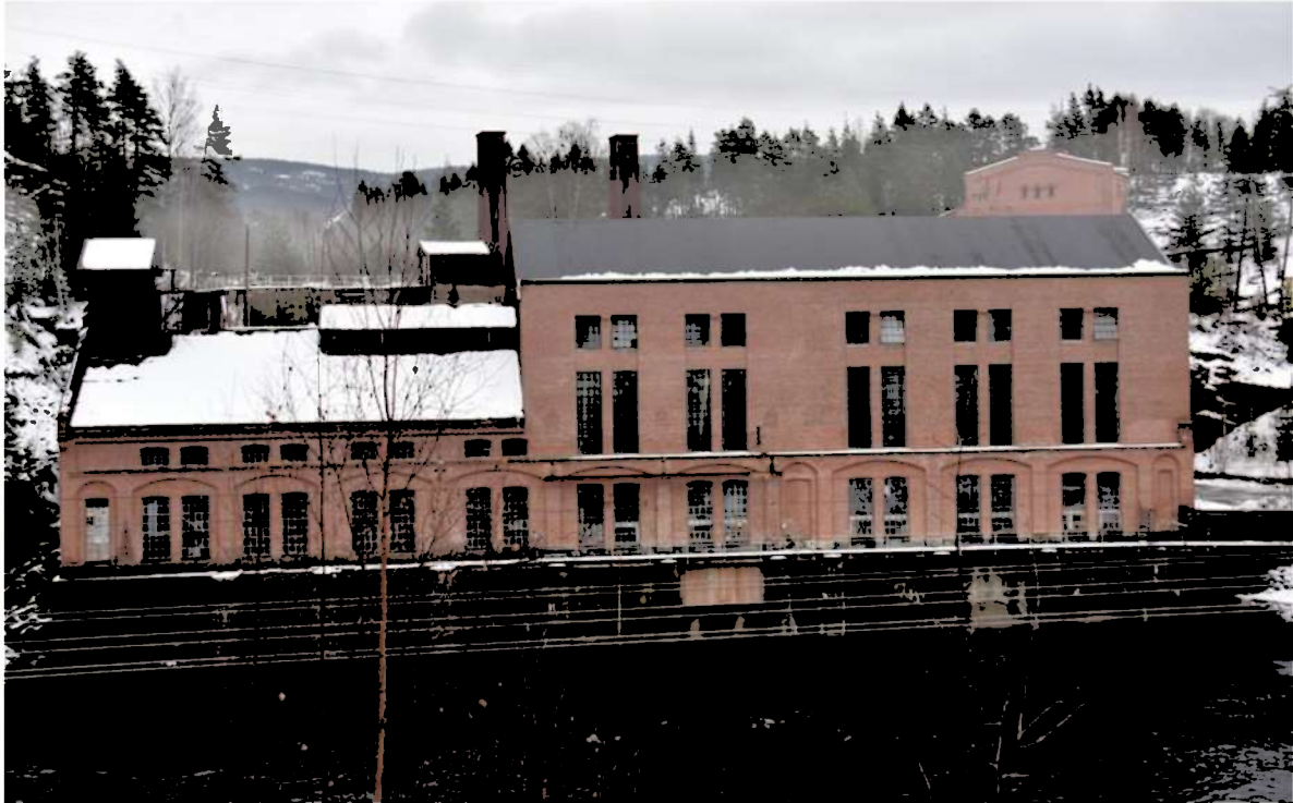
Gravfoss kraftstasjon, bygd 1903.
