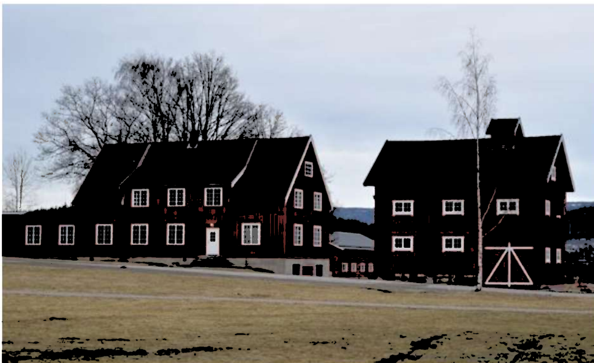
Snekkerverkstedet og magasinet er fra 1911, og er del av det eldste miljøet fra landbrukskolens oppstart. Bygningene er svært autentiske. Begge er i bindingsverk kledd med lektepanel, og vinduer med småruter.
