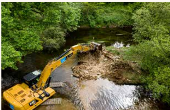
Le seuil du moulin de Lainé, un lointain cauchemar pour les migrants et les sédiments
