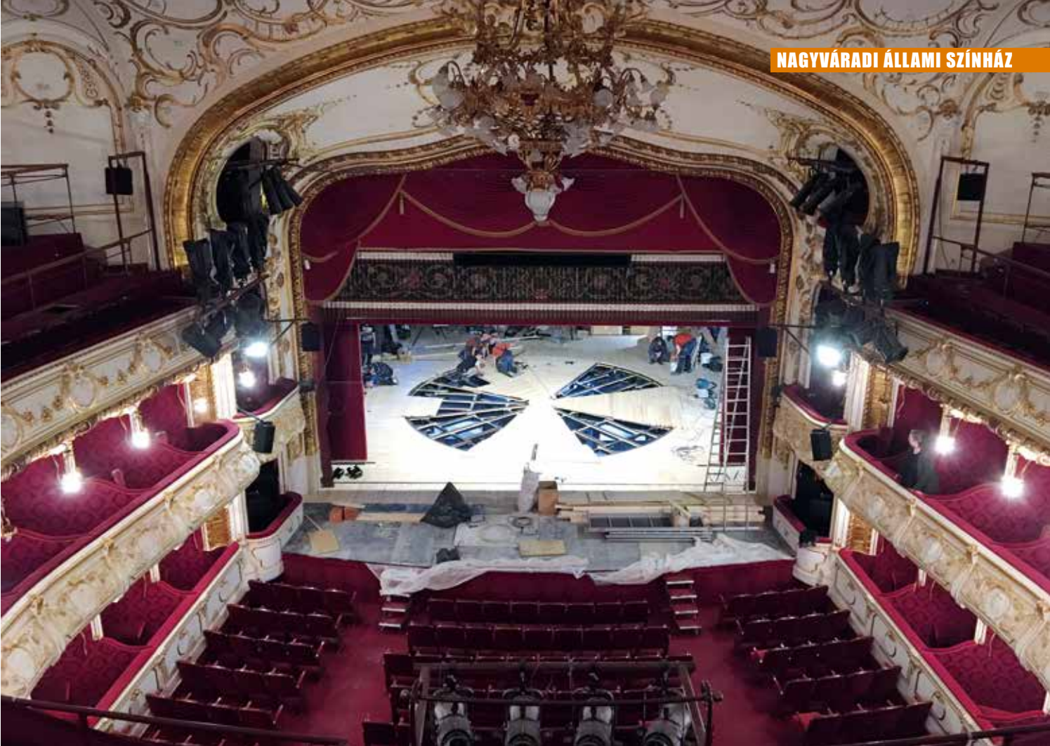
A forgószínpad padlózása a nézőtér felől nézve
