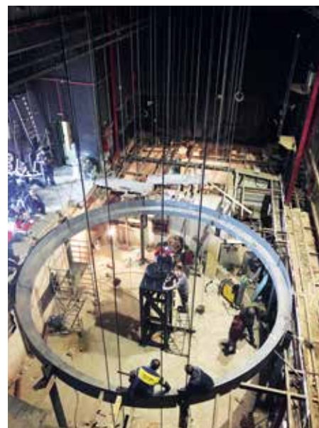
Forgószínpad beszerelése
