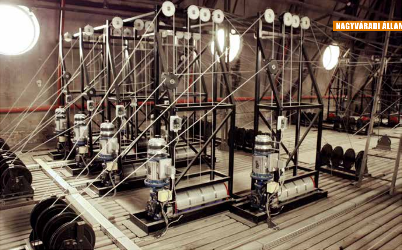
A gépi húzók hajtásegységei a tetőtérbe kerültek
