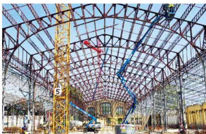
...és a tetőszerkezet felújítása
