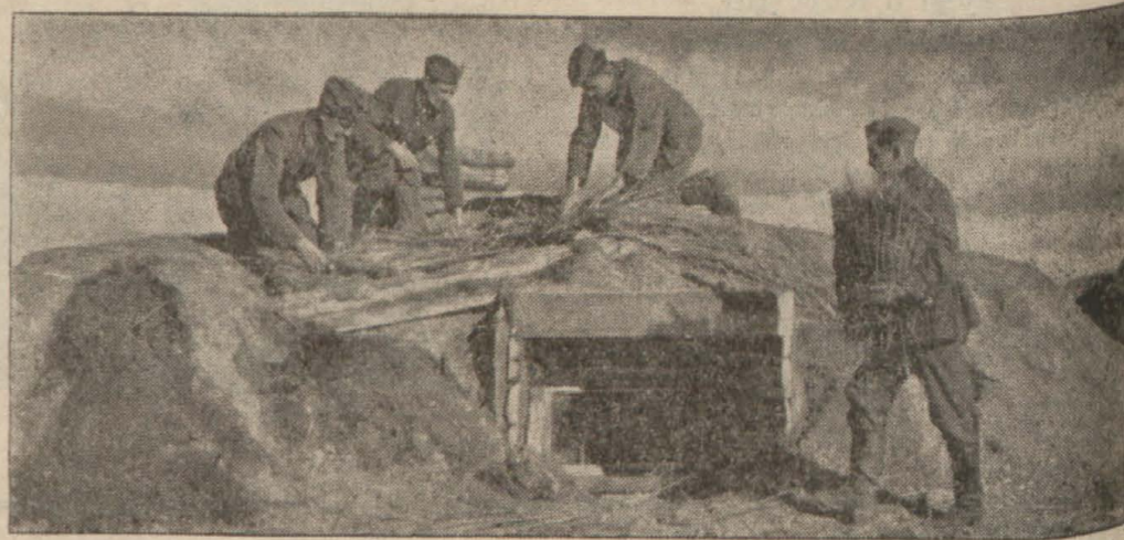
Der Reichsarbeitsdienst baut Blockhäuser für die Wehrmacht. Das fertige Blockhaus wird zum Schlaf mit Erde eingedeckt und mit einer Strohschicht überdacht. Nur der kleine Eingang bleibt noch sichtbar. Auch wenn die Schneestürme darüber jagen, wird es hier drinnen warm sein.
