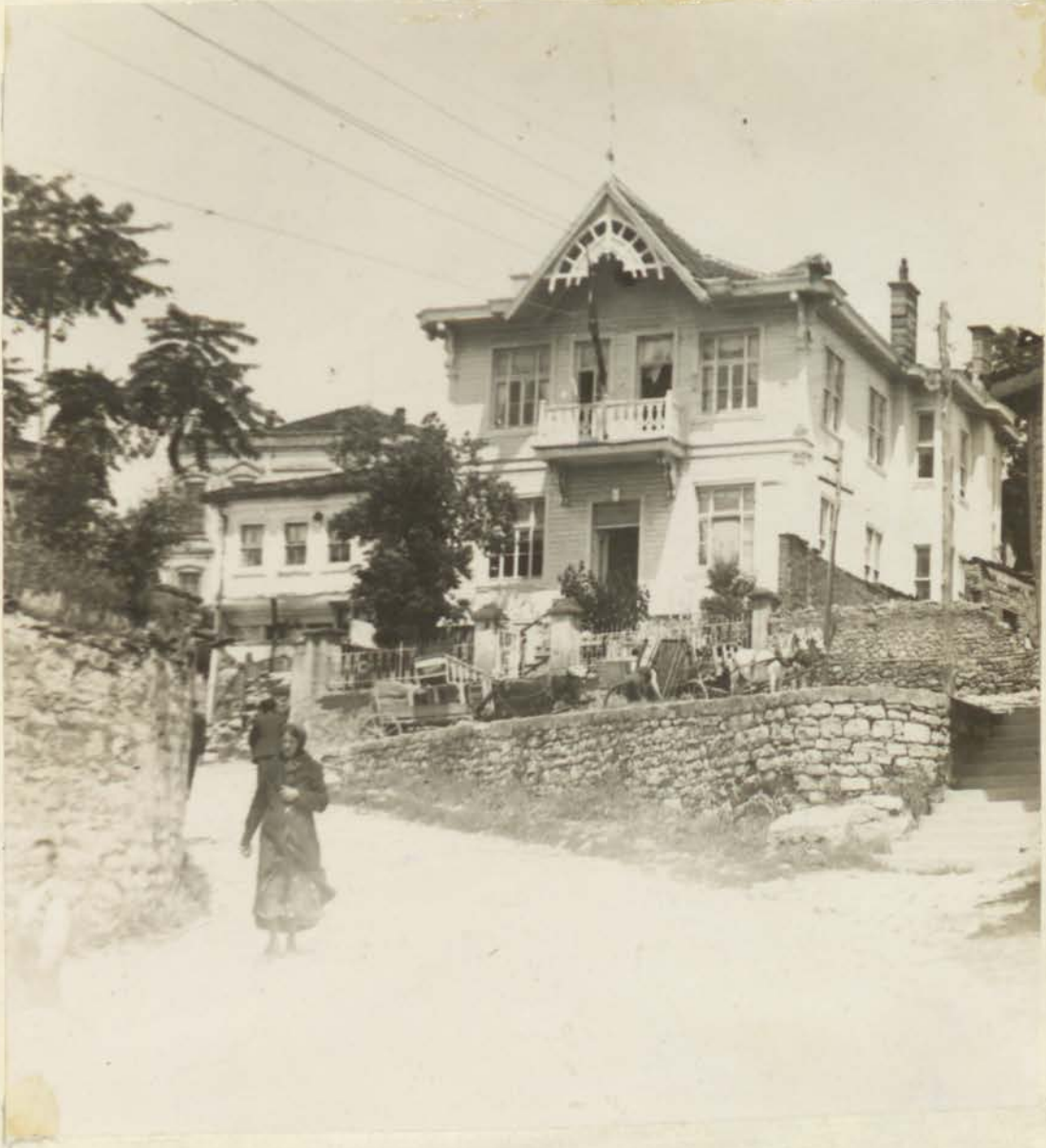
(Kırklarelinin eski tip ahşap evlerinden biri (Eski Hükümet Binası))
