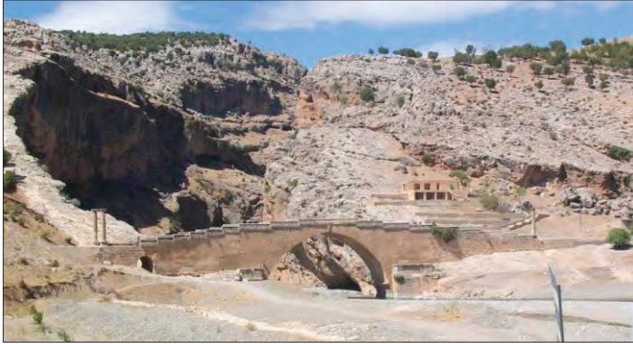
Şekil 4.85: Cendere köprüsü (www.panarmio.com/photo).
