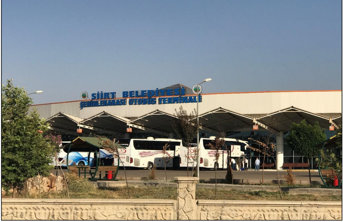
Fotoğraf 124: Siirt Şehirlerarası Yolcu Terminali
