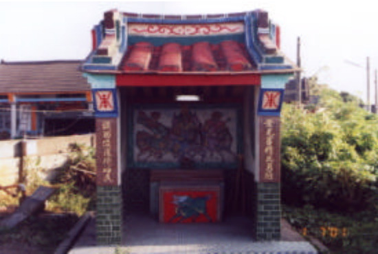
圖 2 - 16、西營外觀，楹聯寫道：安兌宮精兵勇將，鎮西位護境佑民。
