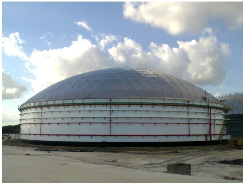
Figura 1.2. Un tanque con techo de domo geodésico de aluminio.
