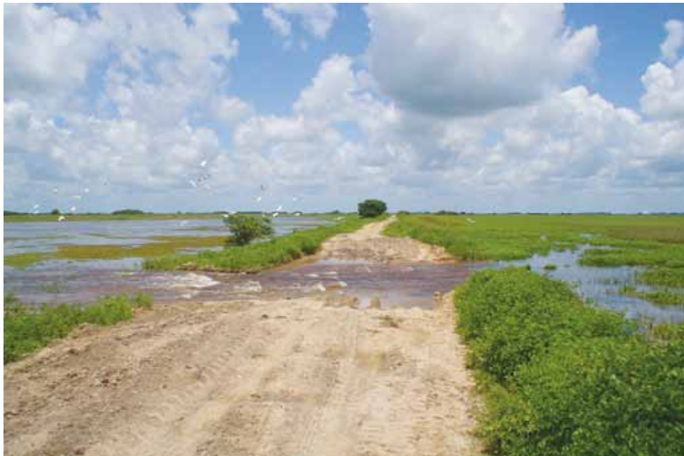
Figura 11.6.7 Rotura del dique Manirito. Foto: A. Rial.
