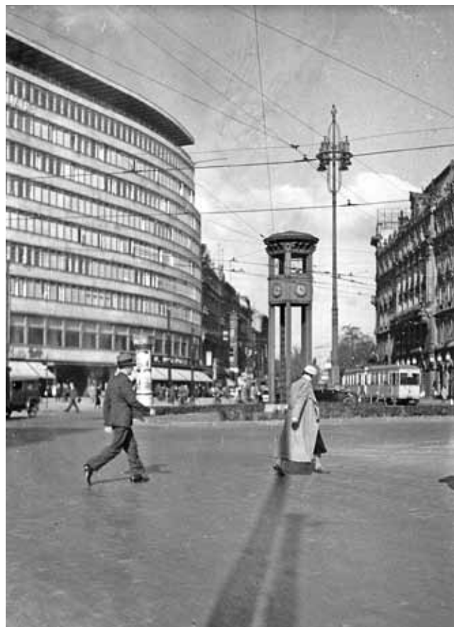
Abb. 14: Berlin, Columbushaus, Potsdamer Platz 1, Blick in die Ebertstraße, zerstört (Aufnahme 1933)
