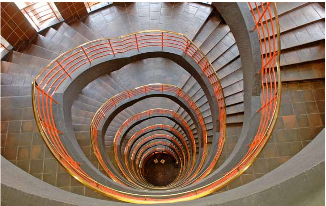
Abb. 13: Sprinkenhof, Treppe im ersten Bauabschnitt
