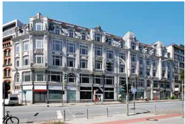
Abb. 7: Holstenhof, 1900–01, Architekt Albert Lindhorst
