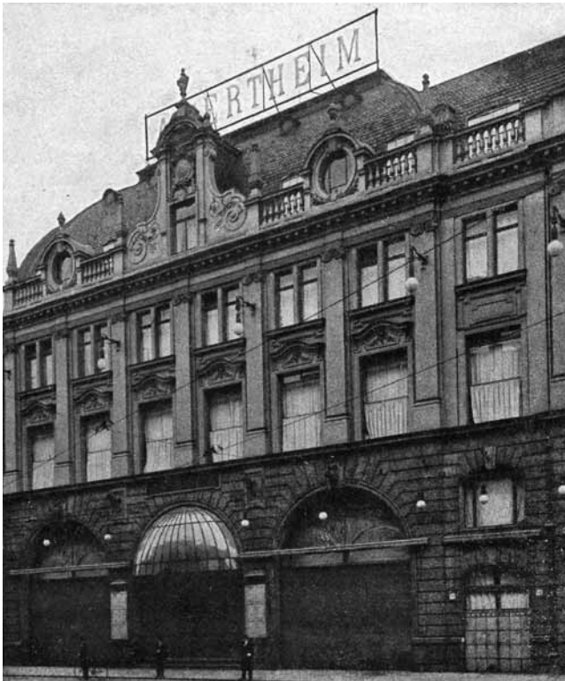
Abb. 3: Berlin, Warenhaus Wertheim, Oranienstraße 53–54, Fassade, zerstört (Aufnahme vor 1900)
