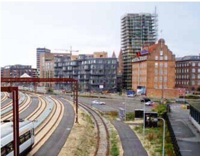
Abb. 10: Blick auf den Südlichen Freihafen mit der ehemaligen Nordisk Fjer-Fabrik (links) und dem DFDS-Bürogebäude vorne rechts (2007)
