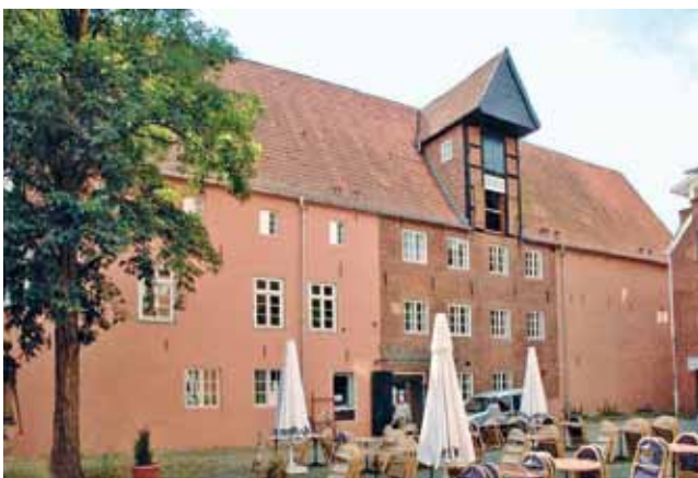
Abb. 3: Bremen, Vegesack, Speicher 17. Jh.
