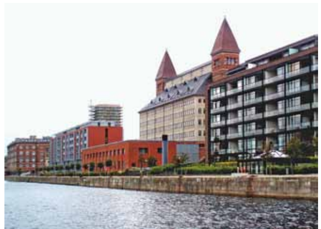
Abb. 12: Neu- und Altbauten auf dem Amerikakai; in der Bildmitte das umgebaute ehemalige Silo Lagerhaus von Levy (auch „Domkirche des Freihafens“ genannt) (2007)
