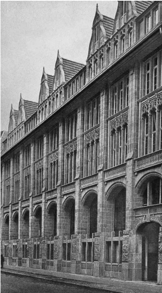
Abb 7: Berlin, Warenhaus Wertheim, Voßstraße 33, Fassade, zerstört (Aufnahme vor 1905)
