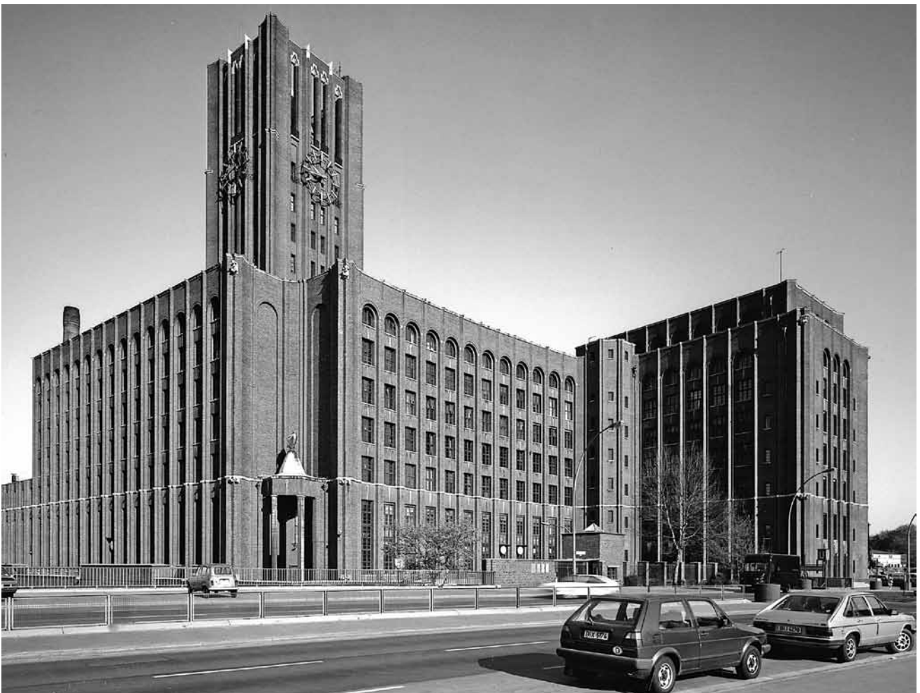
Abb. 12: Berlin, Ullsteinhaus, Mariendorfer Damm 1–3, Gesamtansicht, erhalten (Aufnahme Wolfgang Reuss 1986)
