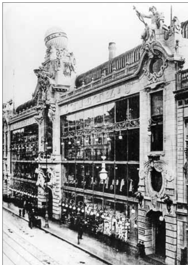
Abb. 6: Berlin, Warenhaus Hermann Tietz, Leipziger Straße 46–49, Fassade, zerstört (Aufnahme um 1900)
