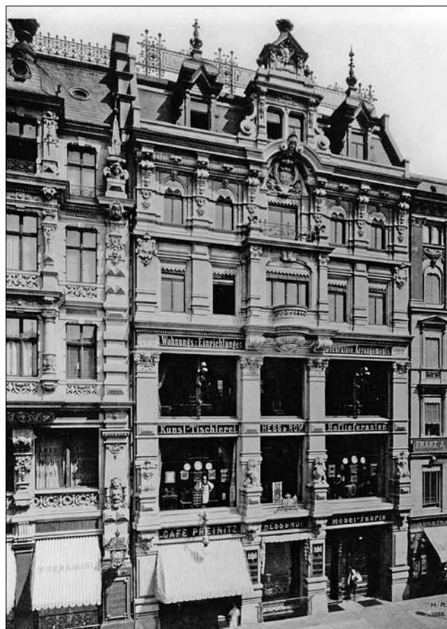
Abb. 1: Berlin, Geschäftshaus, Leipziger Straße 106, Fassade, zerstört (Aufnahme 1888)
