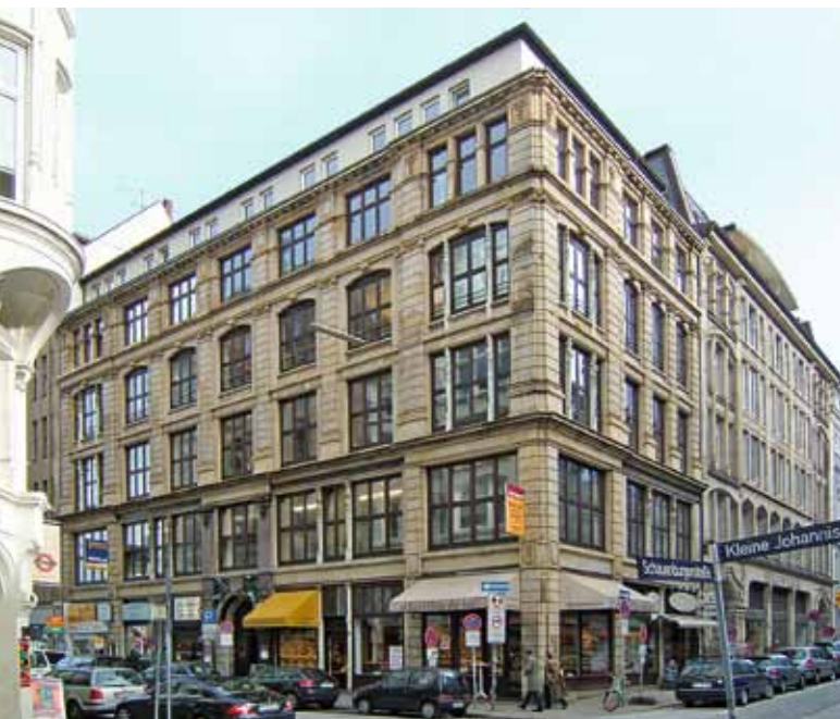
Abb. 5: Johannishof, 1895–96, Architekt George Radel
