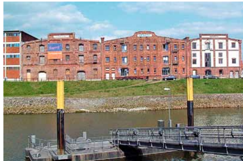
Abb. 12: Bremen, Fabrikenhafen, Bachmannspeicher
