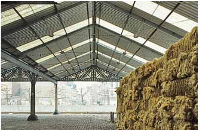
Abb. 9: Die eisernen Lagerschuppen entlang des 1877–1988 erbauten Scheldekais
