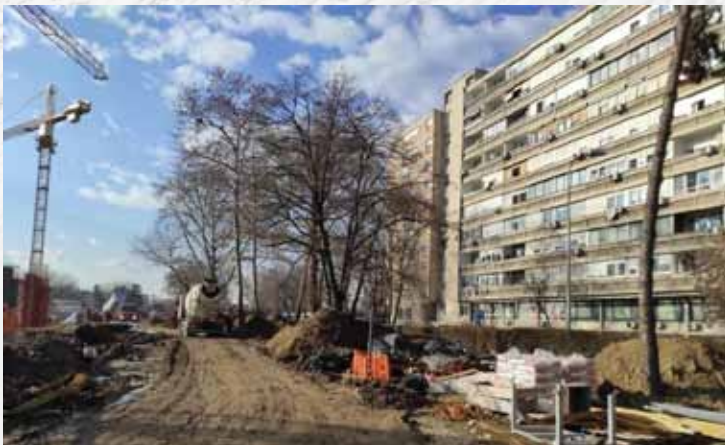
Pogled na gradilište sa sjeveroistočne strane. Foto: Sanja Miloloža
