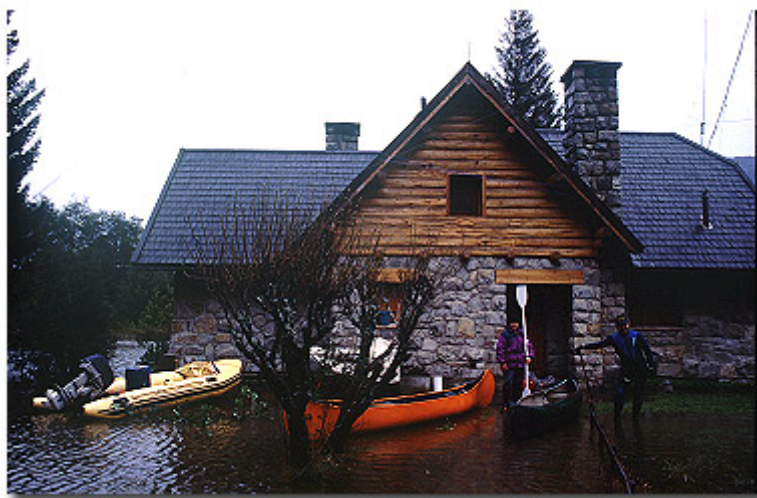
Inundación en Lago Puelo. La fotografía documenta cómo el aumento del nivel del Lago puede inundar toda la cabecera norte, llegando al edificio de la Intendencia del Parque (foto modificada de Administración Parque Nacional Lago Puelo/Felix Vidoz)
