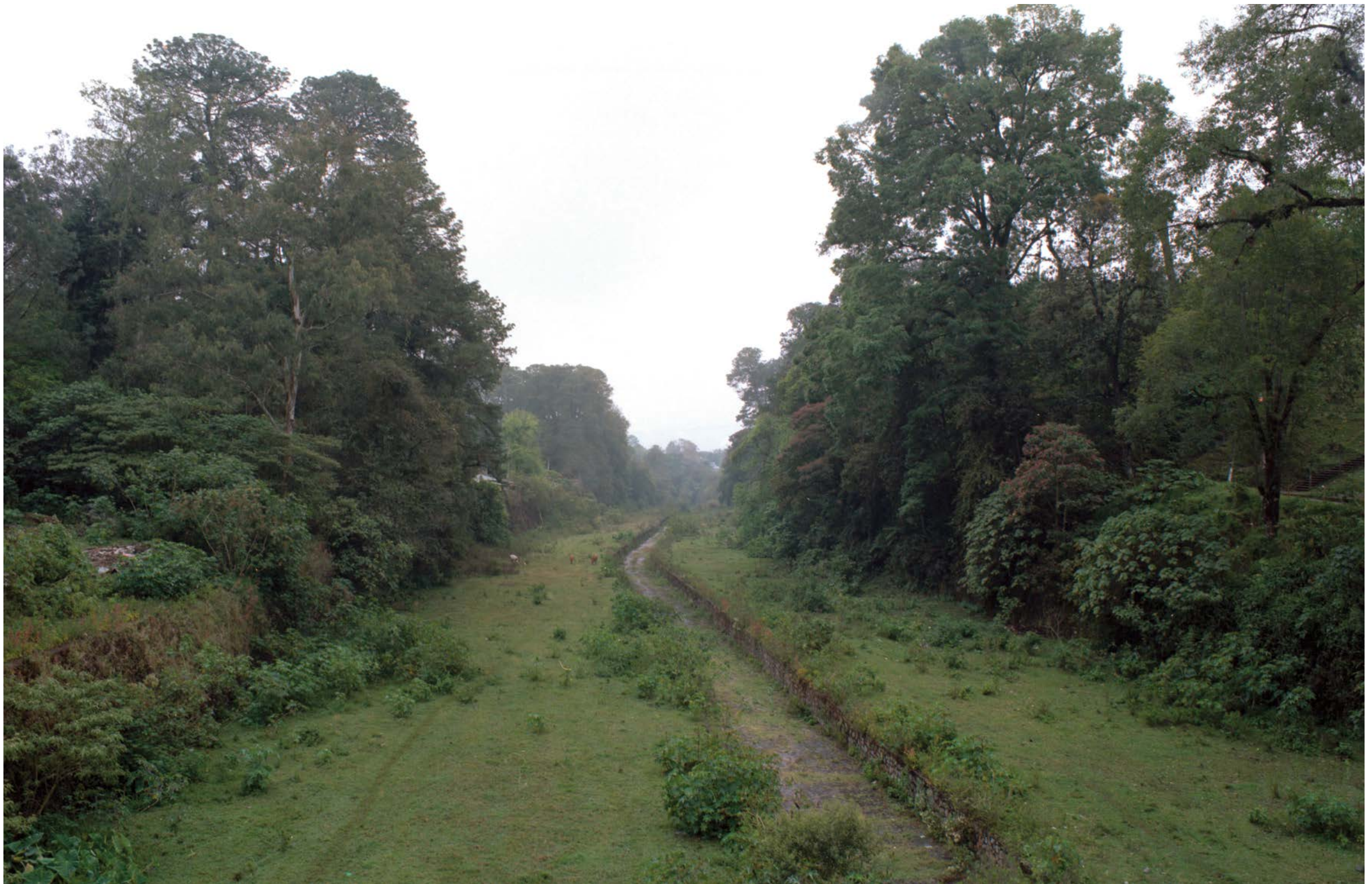
Registro fotográfico. Presa de Nuevo Necaxa, Puebla, 2013.
