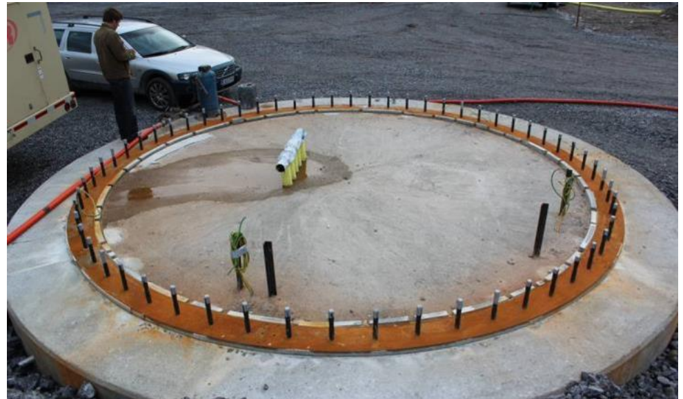
Figur: Exempel på fundament för vindkraftverk. Fundamentets diameter är cirka sex meter.
