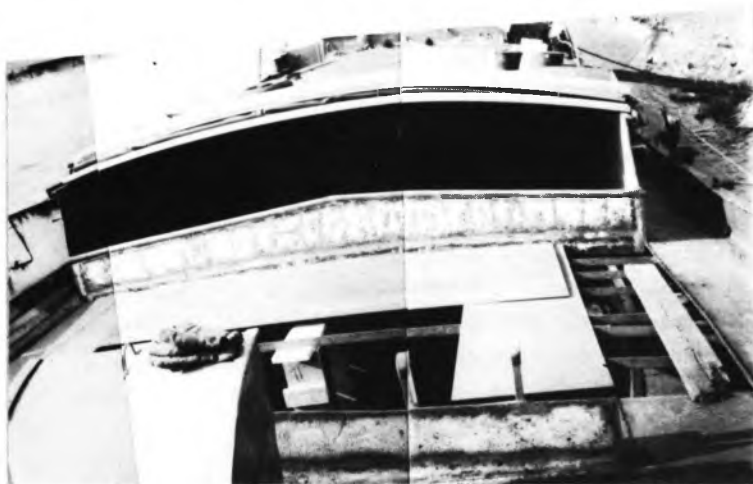
Im Vordergrund der neue Kistluken-giebel, Großluke noch erhöht, mit neuem Giebel, rechts ist zu erkennen, wie weit die Großluke nach vorn verlängert war
