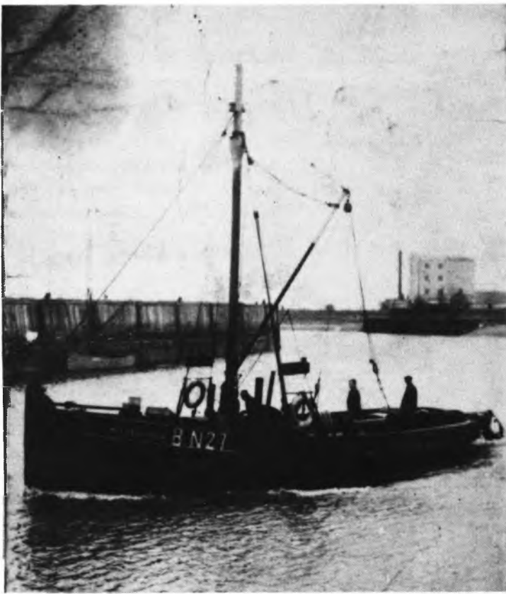
N & L 1934, nach dem Umbau zum Motorkutter; Klüverbaum, Stenge und Gaffel- segel sind entfernt.
