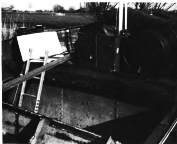
Arbeiten an der Kistluke
