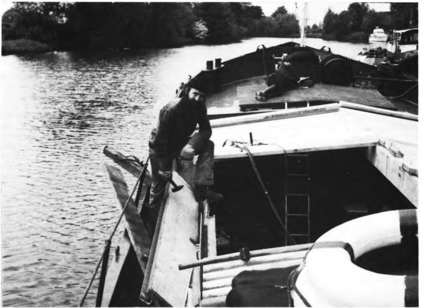
So fiel die Erhöhung der Großluke
