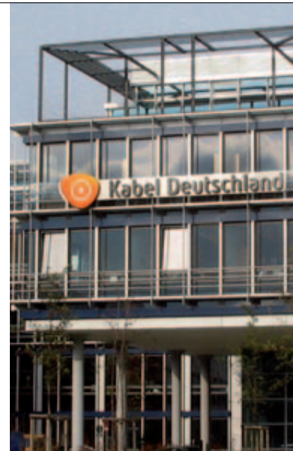
Zentrale von Kabel Deutschland
