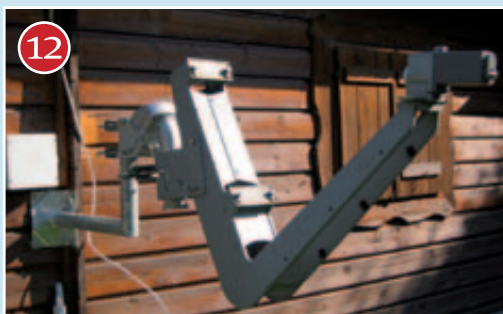
Wegen der einfacheren Handhabung wird erstmal nur das Tragegestell des Spiegels am Motor montiert. Motor und Spiegelarm müssen exakt in einer Flucht sein. Nur so kann die Schüssel optimal eingestellt werden.
