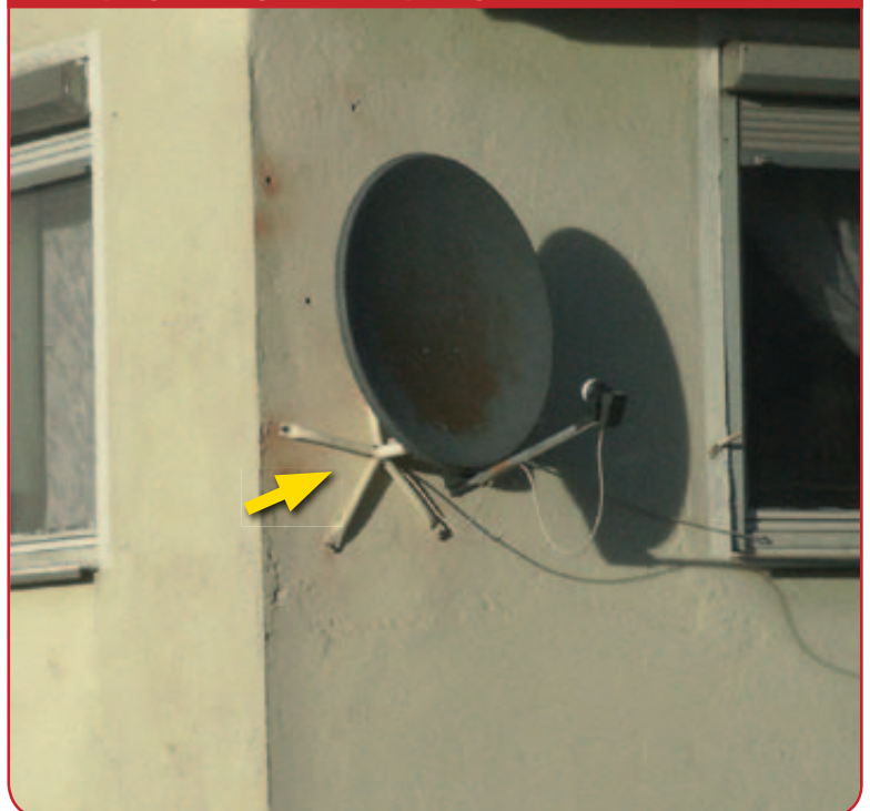
Das Bürostuhlfragment wurde zur Wandhalterung – fünf Schrauben in die jeweiligen Fußenden und das Ding hängt bombenfest; zumindest bis zum nächsten Orkantief
