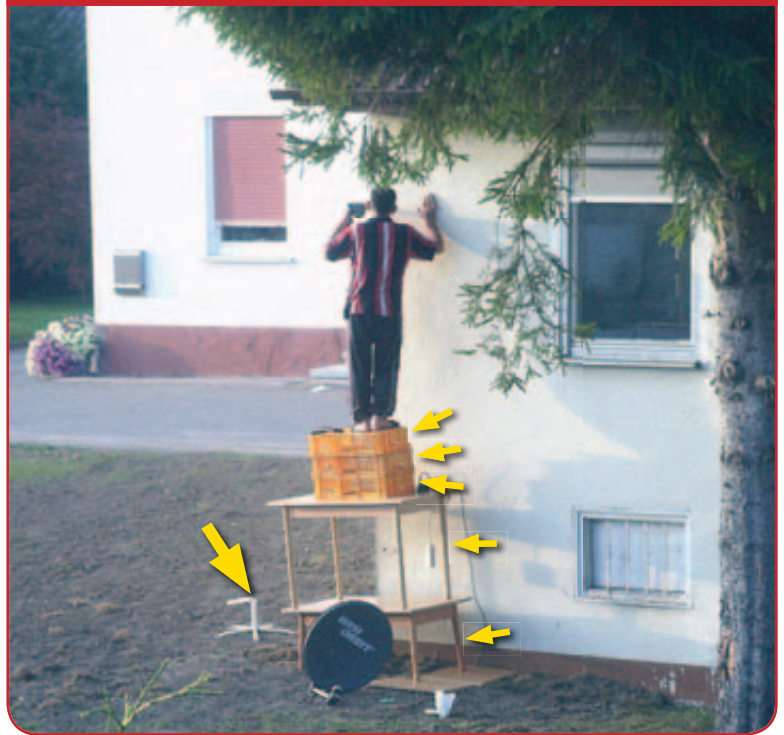
Das abgeknickte Teil (großer Pfeil) kommt von einem Bürostuhl – es hat eine spezielle Funktion
