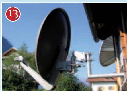
Fix fertig montiertes System. Bedingt durch den Motor steht die Schüssel nun etwas weiter vor.
