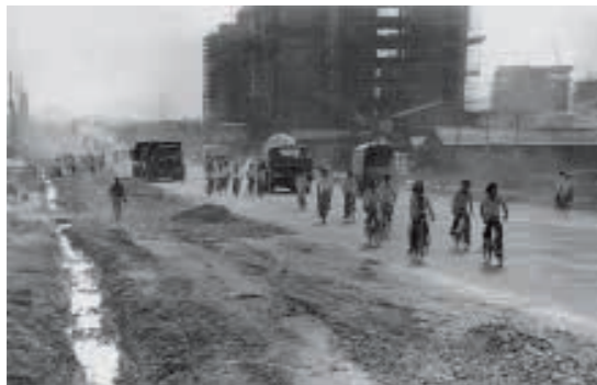
20世纪80年代初，从东向西看深南大道，右为施工中的电子大厦。
