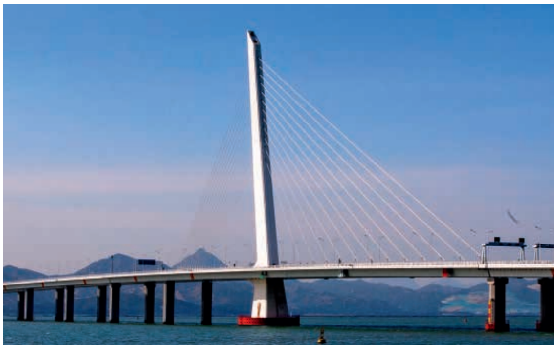
深圳湾公路大桥独塔钢梁斜拉结构。
