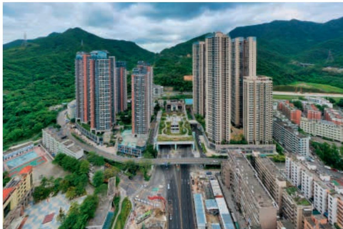
梧桐山隧道盐田段出入口。
