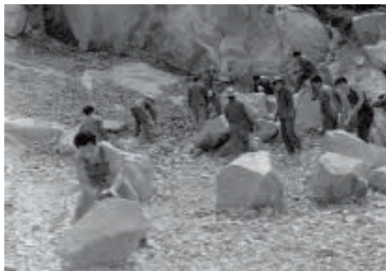
1980年初，深南大道从上海宾馆到南头检查站路段，几乎都是这样的石头山，两万基建工程兵转业深圳后成立的建设公司把这些石头山搬平。
