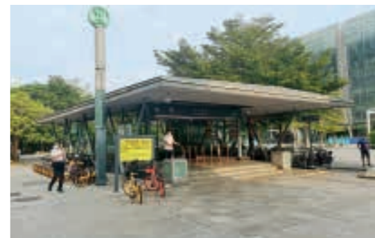
地铁1号线竹子林站。
