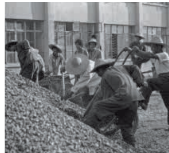
1982 年，和平路改造施工。
