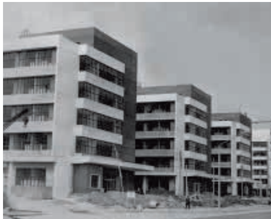
20世纪80年代，由转业深圳的基建工程兵组成的施工队开发建设华强北工业区。
