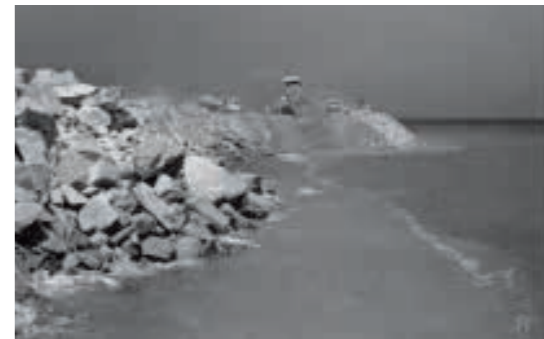
20世纪80年代，深圳经济特区建设中的移山填海。
