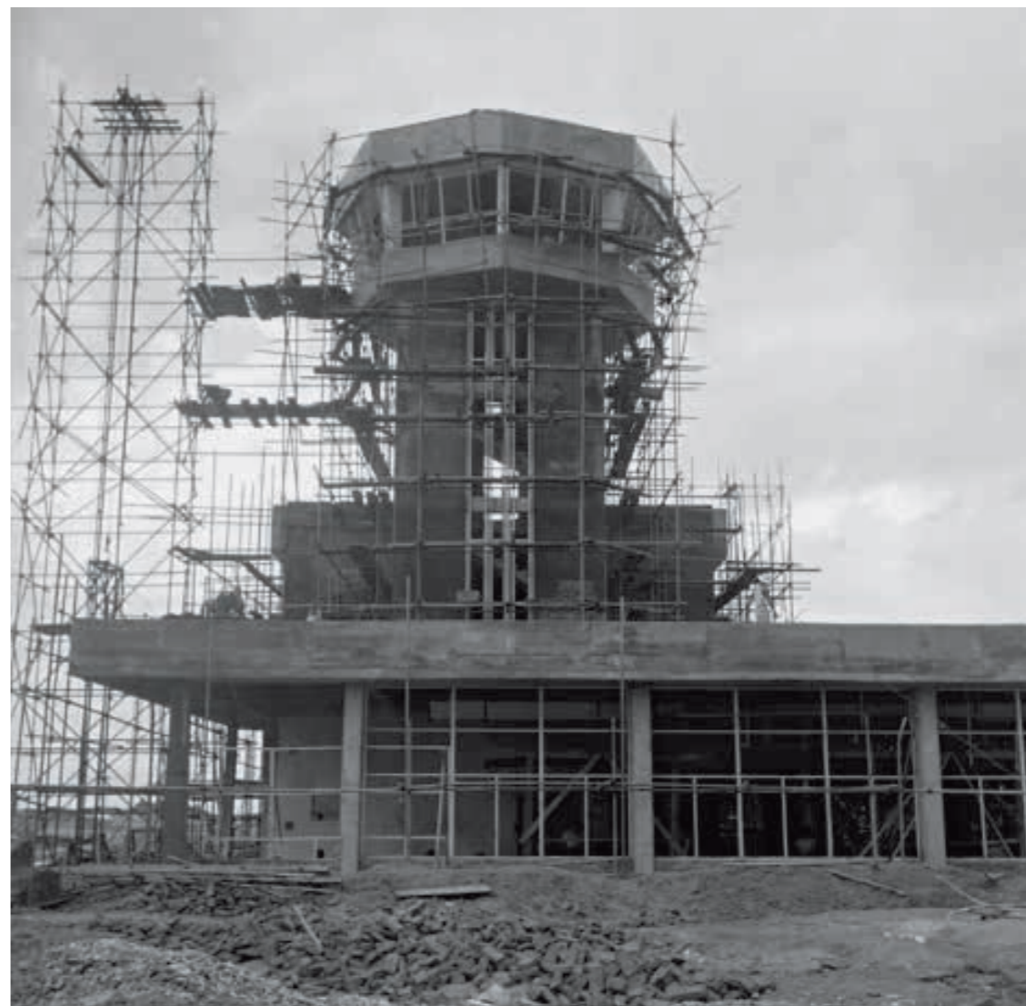
1983年，深圳经济特区的第一个机场是深圳市南头直升机场，由基建工程兵302团承建。图为候机指挥楼全景。
