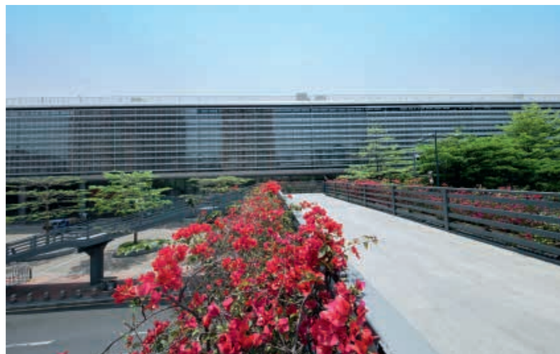
福田口岸过街天桥。
