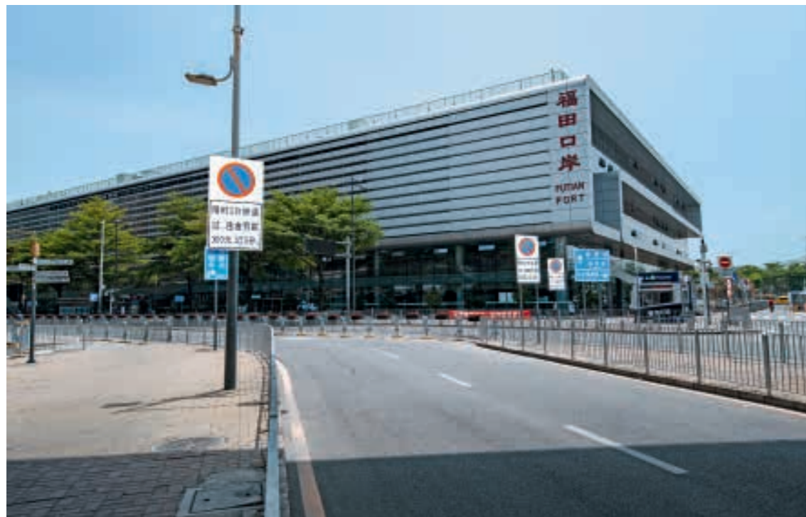
福田口岸边检楼。
