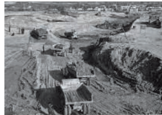
20世纪80年代初，深圳经济特区初建时期，基建工程兵承建了很多土石方工程施工任务。
