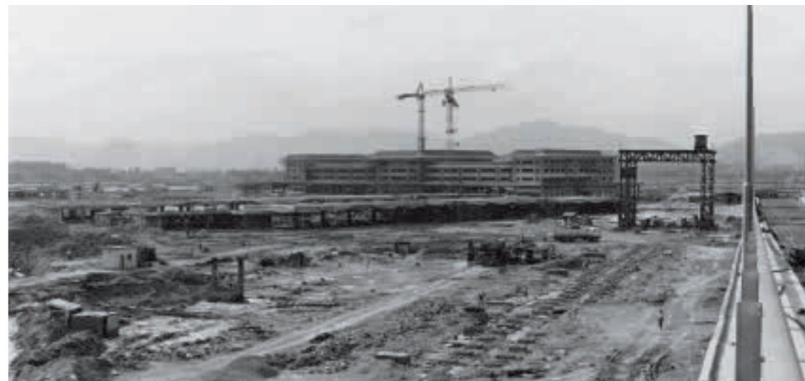
20世纪80年代，施工中的皇岗口岸。
