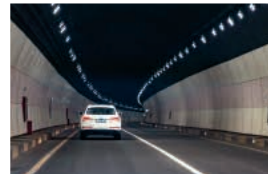
梧桐山隧道内景。
