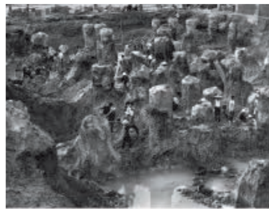
1981年，深圳经济特区建设初期，缺少大型机械设备，建设者们不等不靠，土法上马挖建红岭大厦基础工程。
