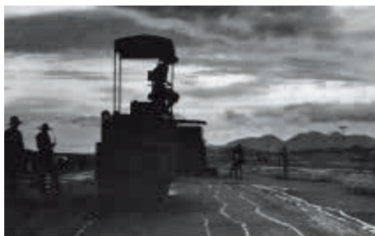
1982年，建设中的笋岗路。
