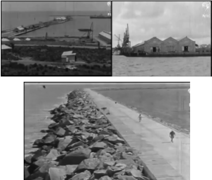
Figura 6: Construção do Porto de Takoradi 1921-1928
