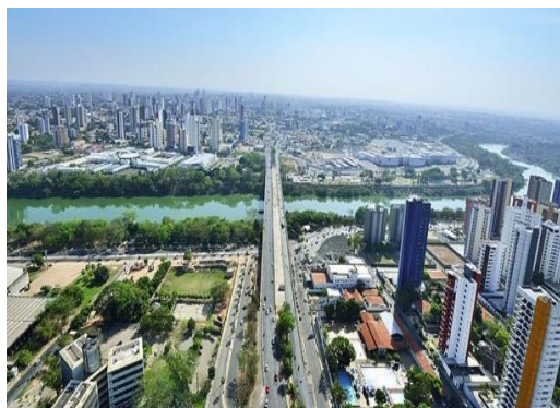
Figura 17 - Ponte de concreto Juscelino Kubitschek, dias atuais. Fonte: uol 69 .
