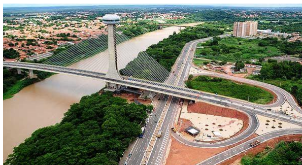
Figura 40 - Construção dos acessos da Ponte Estaiada, 2010 Fonte: Jornal da Parnaíba 133 .
