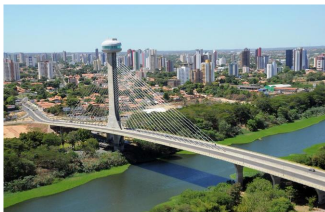
Figura 39 - Ponte Estaiada sobre o rio Poti (2021) Fonte: Segue viagem 132 .
