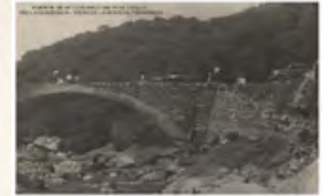
VISTA DE LA BÓVEDA TERMINADA, RÍO ANGOSTURA
