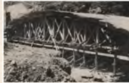
CONSTRUCCIÓN DEL PUENTE DE HORMIGÓN, RÍO ANGOSTURA
