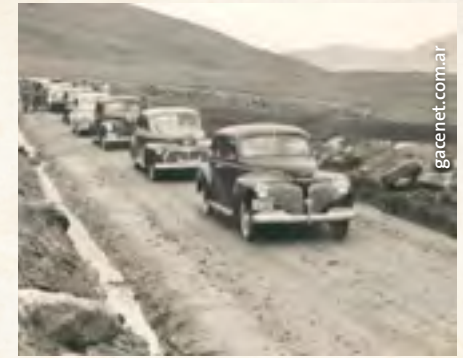
OBRA DEL CAMINO A TAFI DEL VALLE. 1940.
