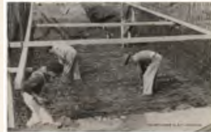
CONSTRUCCIÓN DEL TRAMO SANTA LUCÍA - LA RAMADITA
